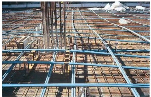
Fig. 2.19– Ilustração de cordoalhas engraxadas disposta em uma laje
