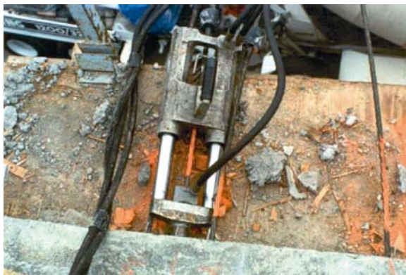
Fig. 2.18– Macaco de protensão monocordoalha
