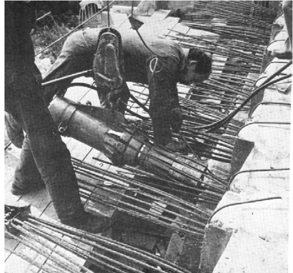
Fig. 2.15– Ilustração de macaco de protensão multi-cordoalha
